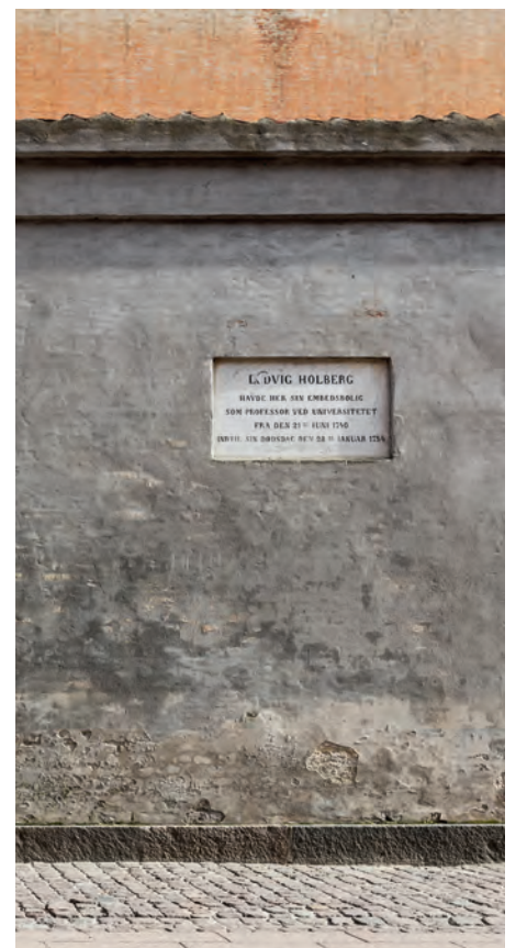
Pudset mur i Fiolstræde.
