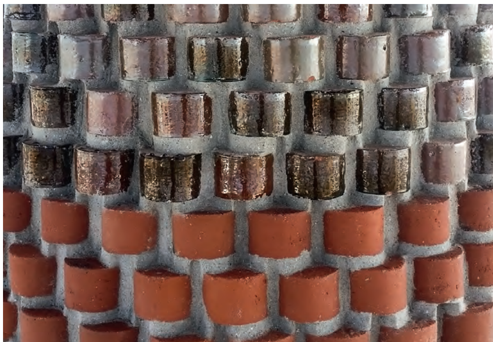
Udsnit af det restaurerede spir med glaserede og uglaserede sten.
