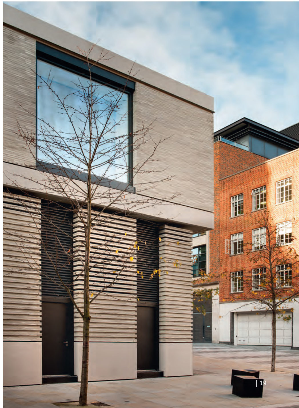
Murstenens særlige egenskaber er anvendt til at variere murværket, så de bagvedliggende funktioner kan aflæses. I bygningsdelen med adgang til P-anlæg er murværket udført i to skifter med mellemrum på 10 cm, som giver en smuk mønstervirkning og naturlig ventilation til kælderen.
