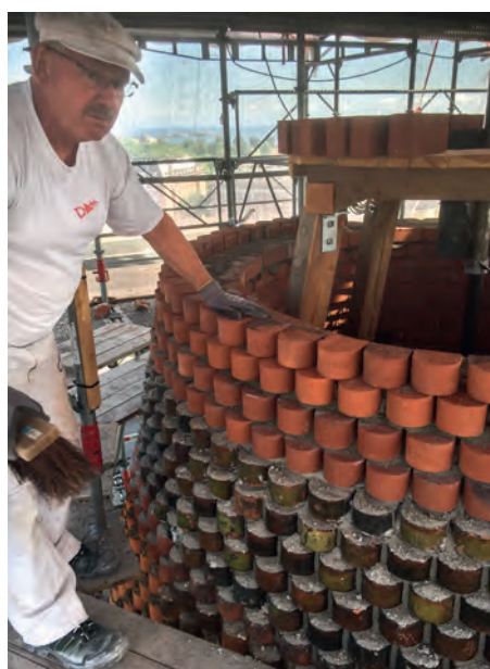
Opmuring af spiret foregik ved hjælp af et rundstik, der i praksis er en overdimensioneret passer.
