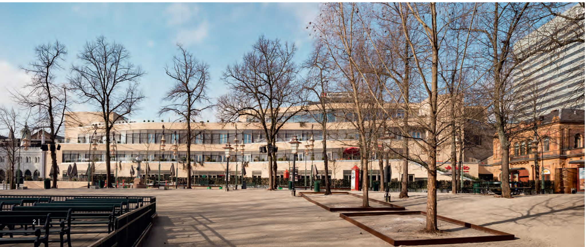
I kraft af facadens terrasserede udformning opleves bygningen mod haven lavere end sine trettent meter. Tivoli og Pei Cobb Freed & Partners ønskede, at denne facade skulle beklædes med tegl og udviklede en specialudgave af Petersen Cover, hvis gule og grå nuancer fanger farverne i begge nabobygninger, henholdsvis Nimb Hotel og Tivolis hovedindgang.
