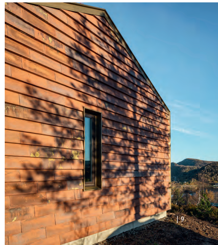
Cover ligger på klink og monteres på en bagvedliggende trækonstruktion. Facadeudtrykket giver mindelser om traditionel, norsk træbeklædning.
