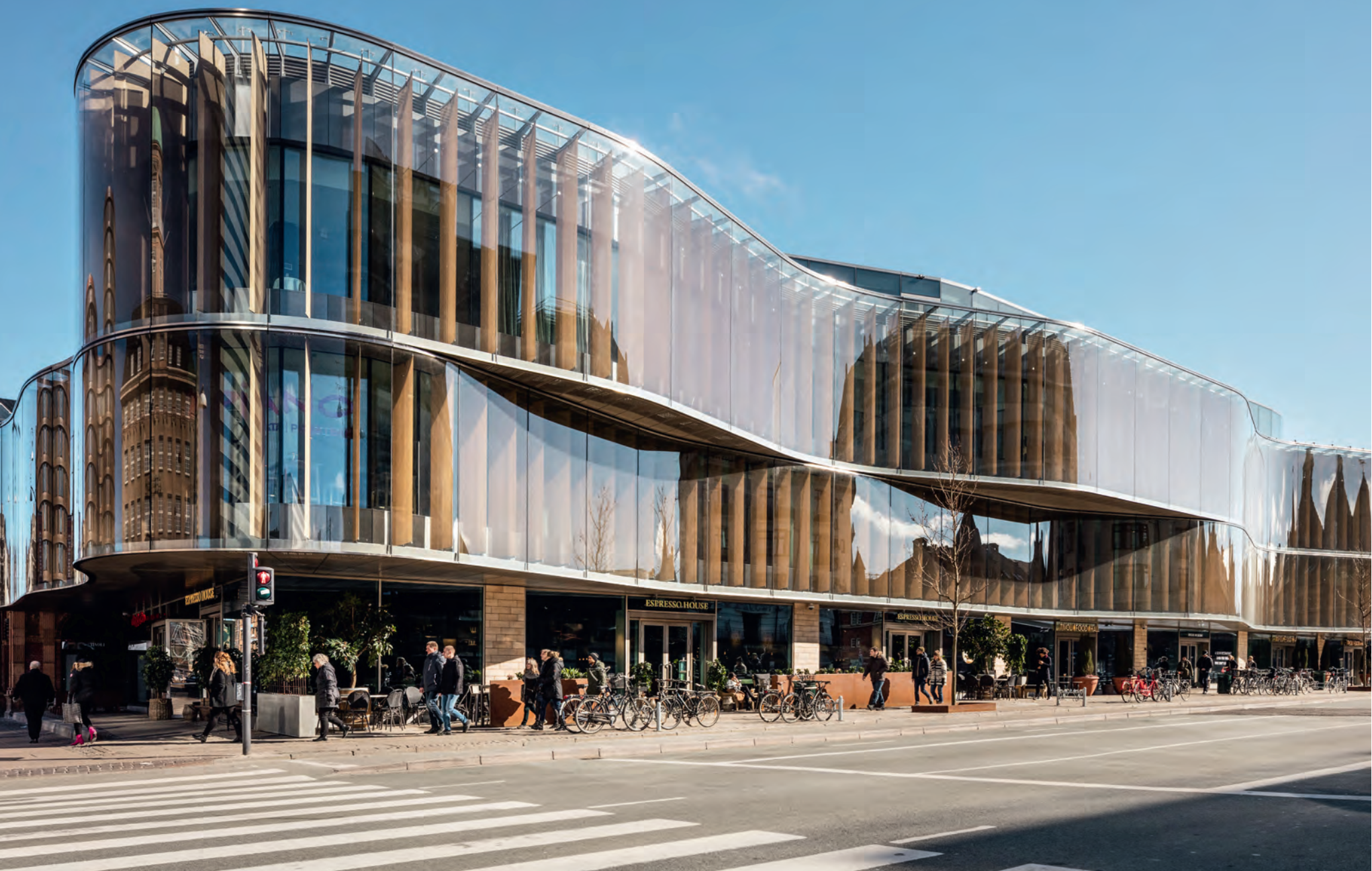
Tivoli Hjørnets facader mod Bernstorffsgade og Vesterbrogade er udført som to bølgende glasbånd med inkorporerede, lodrette lameller. Lamellerne, der kan drejes om deres lodrette akse, giver solafskærmning og varierer samtidigt ind- og udkig. Den tilbagetrukne stueetage kombinerer glaspartier med brede søjler beklædt med en specialudgave af Kolumba udført i samme ler som teglet, der beklæder havefacaden.
