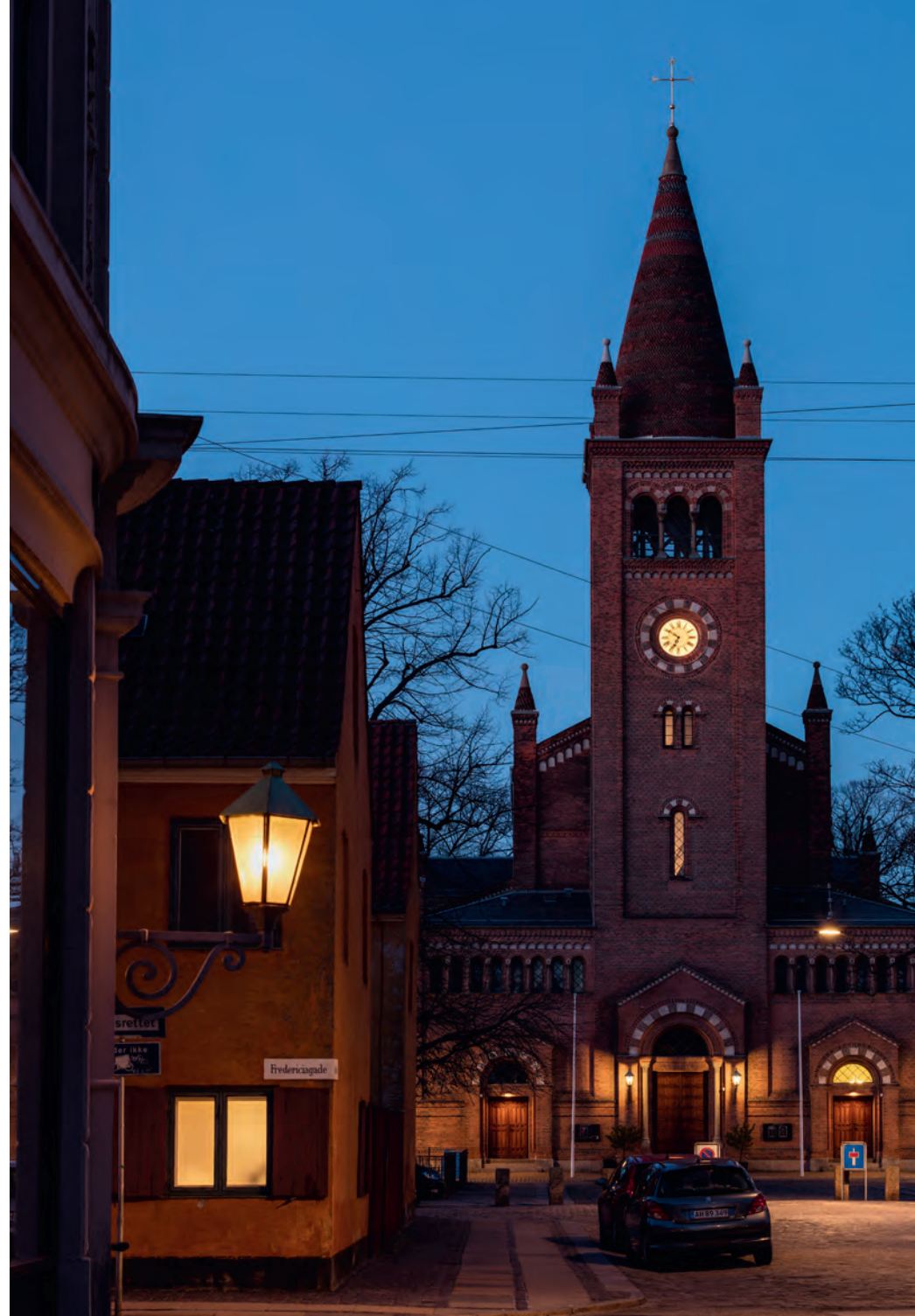
Som led i restaureringsarbejdet blev der installeret lys bag nye urskiver af glas på tårnets ure.
