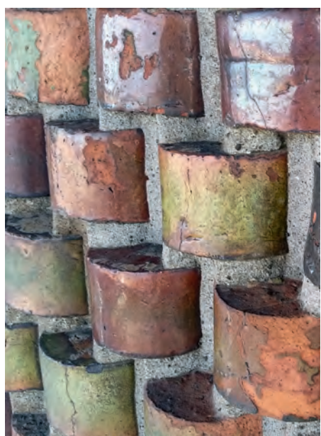
De øverste teglskifter på det 140 år gamle spir var efter fugtskader klar til udskiftning.
