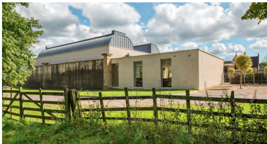
Udelukkende indgangspavillonen er helt synlig, selve galleribygningen er delvist skjult bag de gamle mure.
